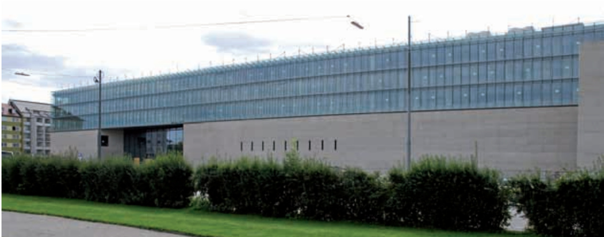
Baustelle Construction site
