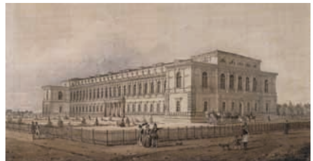
Erster Bau der Neuen Pinakothek (1853) von Südosten um 1840/50 First building of the Neue Pinakothek (1853) from south east 1840/50 Bild: Münchner Stadtmuseum
